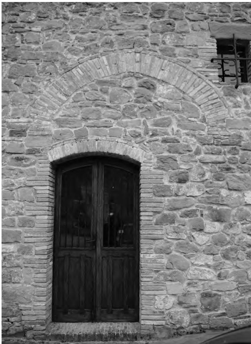
*Fig. 6 - Traccia dell'arcata d'ingresso sulla parete nord. Si noti il forte schiacciamento subito a causa del peso del muro sovrapposto.*
