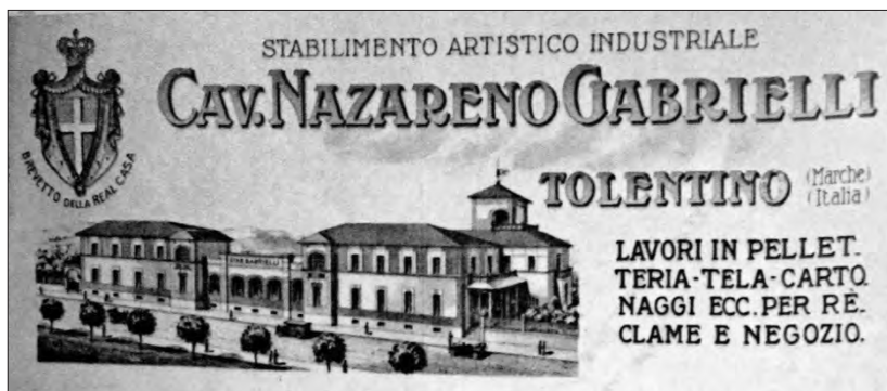
Nuovo stabilimento NAZARENO GABRIELLI, lungo viale Cesare Battisti, sede storica riprodotta nella carta intestata dell'Azienda. L'edificio, noto come «palazzina GABRIELLI», fu «esempio tipico di architettura industriale con più funzioni: abitativa, produttiva, espositiva».
