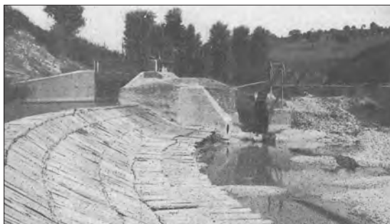
Costruzione di un nuovo percorso del Canale Vallato di derivazione dal fiume Chienti della lunghezza di un chilometro, con un salto di quattordici metri, utile per la Centrale idroelettrica del "Littorio".
