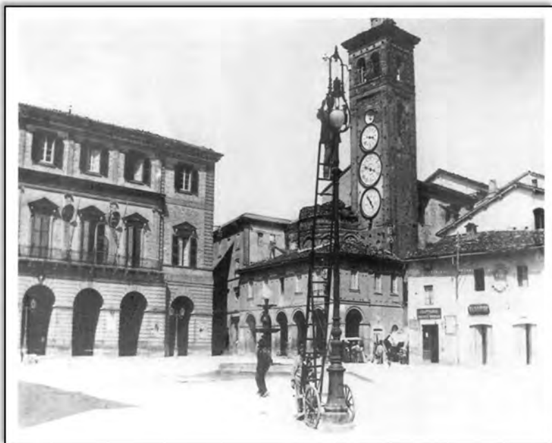
Montaggio di un lampione dell'illuminazione elettrica in piazza Vittorio Emanuele II a Tolentino. L'impianto elettrico cittadino, inaugurato dal sindaco GIOVANNI BENADDUCI, cominciò a funzionare dal settembre 1892.
