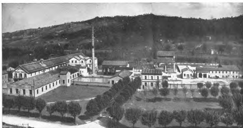
VEDUTA PANORAMICA DELLA CARTIERA V. PORCELLI
