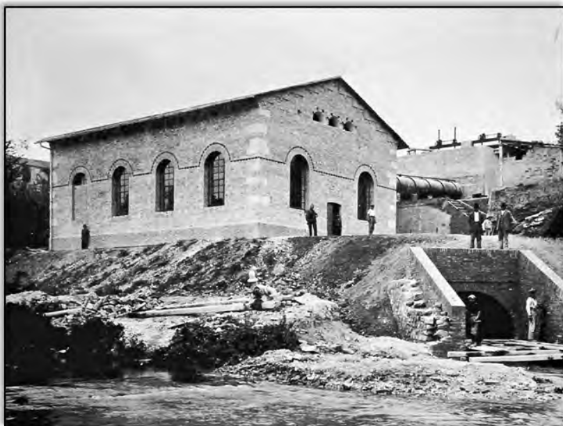
Centrale idroelettrica del “Littorio” (poi del “Ponte”), impiantata nel 1926 sulla riva sinistra del Chienti. Aveva una potenza media di 850 cavalli vapore.
