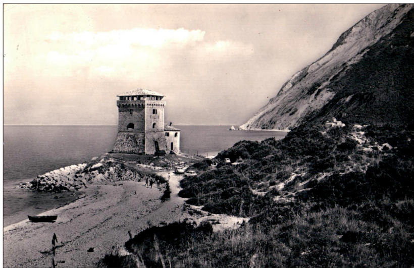
Fig. 8 - Torre di Portonovo, oggi Torre De Bosis, cartolina della prima metà del Novecento.
