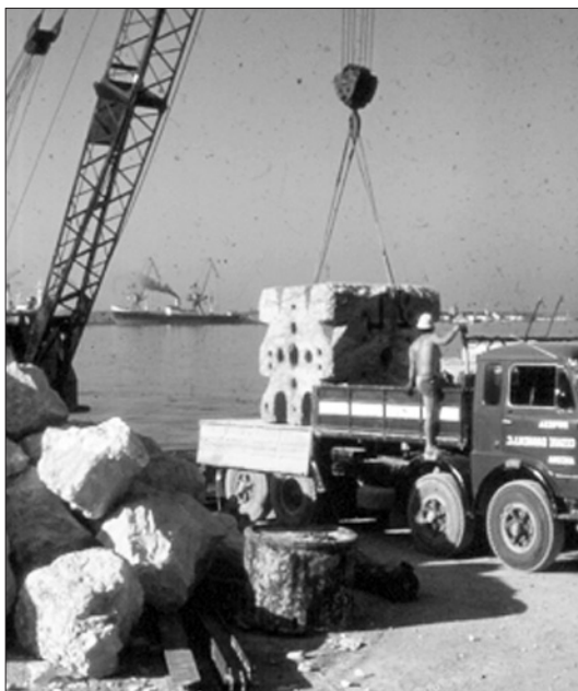
Fig. 3 – Massi di calcare che, in accumuli, verranno immersi tra una piramide e l'altra per dare continuità al sistema ecologico della barriera.
