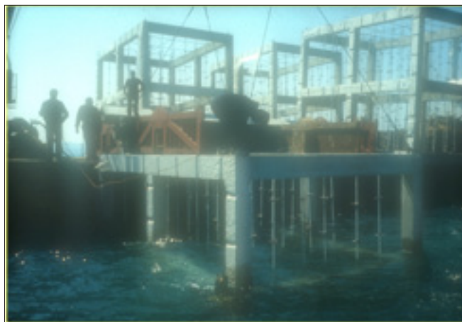
Fig. 10 – Immersione di gabbioni in cemento, preparati a fini di mitilicoltura.
