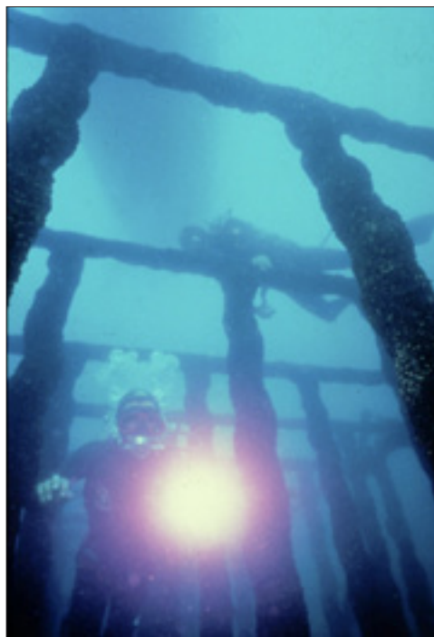
Fig. 8 - Gabbione in elementi metallici tubolari per la mitilicoltura nell'area marina di Portonovo, presso Ancona.
