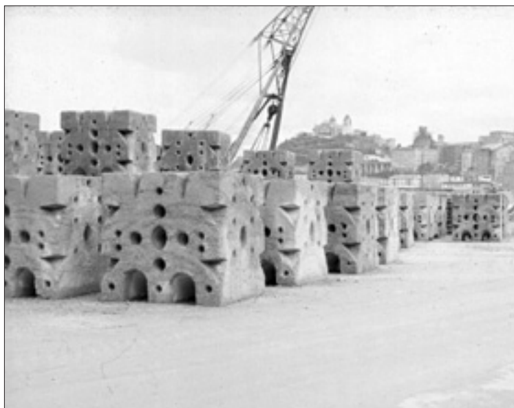
Fig. 2 – Blocchi di calcestruzzo pronti in banchina per essere imbarcati ed essere trasportati nella zona di ripopolamento.
