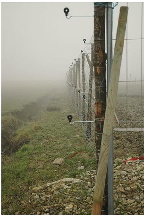
*Figura 176 – Recinzione metallica anti-lupo attrezzata con supporti a mensola per il passaggio del filo conduttore*
