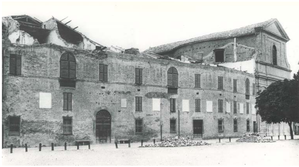
Il vecchio ospedale civico, adiacente alla chiesa della Maddalena (a destra), in via Cavallotti, crollato durante il terremoto. Oggi sull'area sorge un padiglione dell'Opera Pia Mastai-Ferretti (foto già edita in Cecilian-Negri, Il terremoto del '30. Immagini e testimonianze , Stampa Nova, Jesi 1991, pp. 40-41).
