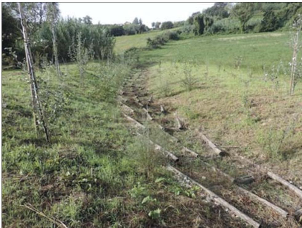
Fig. 19 – Lavori di riprofilazione del terreno, interventi di protezione del fondo del fosso effettuati con opere di ingegneria naturalistica e piantumazioni di specie forestali in fasce diversificate su base morfologica sulle sponde.
