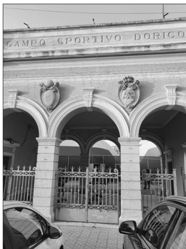
Ingresso dello Stadio dorico.
