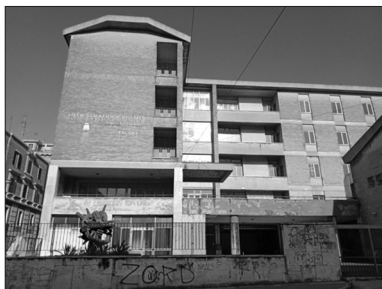
L'edificio del Savoia ora in disuso.
