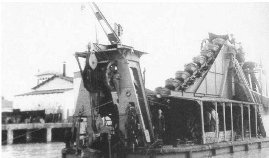
**Fig. 23. Draga al lavoro di escavazione dei fanghi nel porto**
